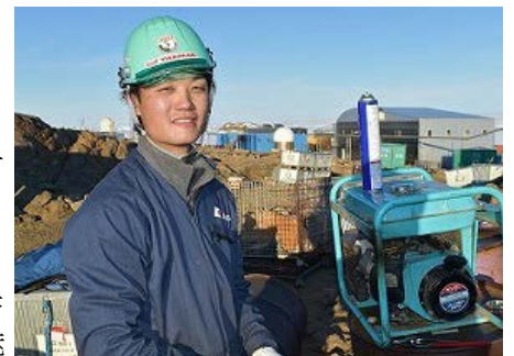
ヤンマー製発電機点検中
