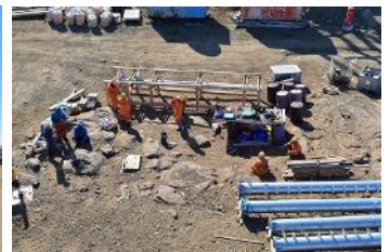
休憩時。足場の上から。
