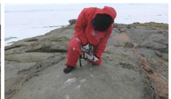
ハンマードリルで穴開け作業
