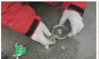
ボルトと接着剤で固定
