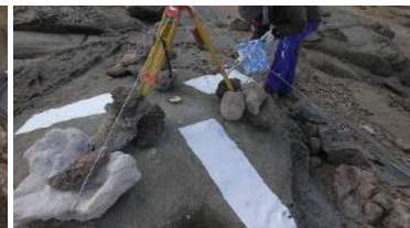
対空標識のペンキ塗り
